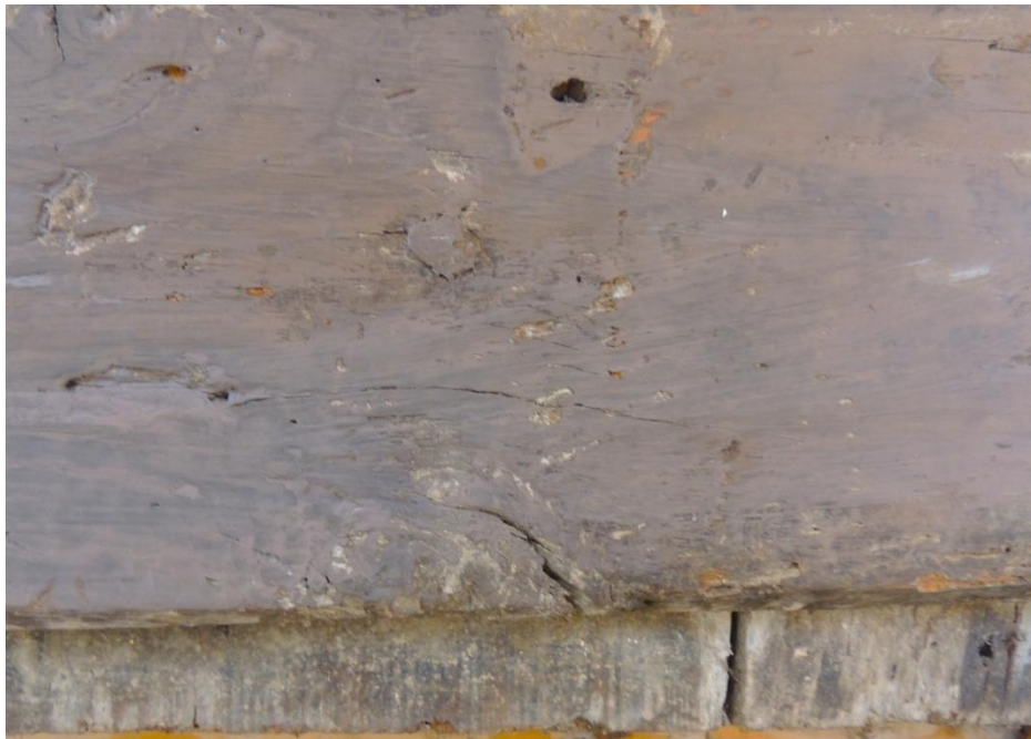
Πλαστική παραμόρφωση και ρηγμάτωση ξύλου στα σημεία των ρόζων που οφείλεται σε θερμο/υγρασιακές διακυμάνσεις του μικροκλίματος έκθεσης και διατήρησης (αρχείο Κ. Στουπάθη)
